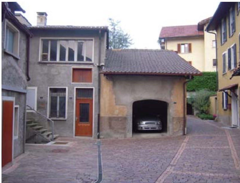
vista da est edificio 28 sub A
