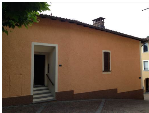
Vista facciata fmn 462 via dei Camuzzi
