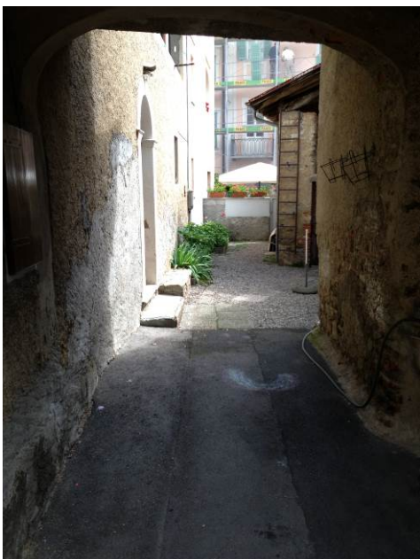
Vista portico da via Ra Carà
