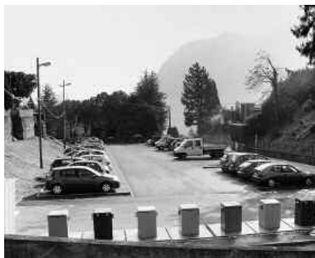
Il nuovo posteggio in via dei Gilardi, dopo la sistemazione
